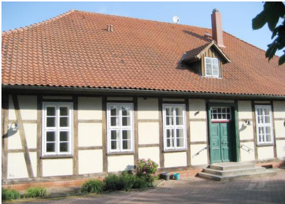
Abbildung 9: Gemeindehaus, Blick vom Süden auf den Haupteingang
