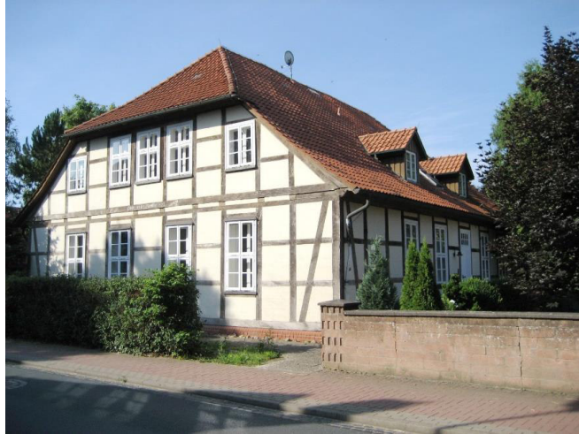
Abbildung 8: Gemeindehaus, Ansicht von Nordosten (Hauptstraße)
